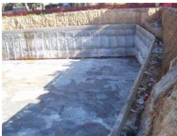
Δημιουργία στεγανολεκάνης κατά τη θεμελίωση
